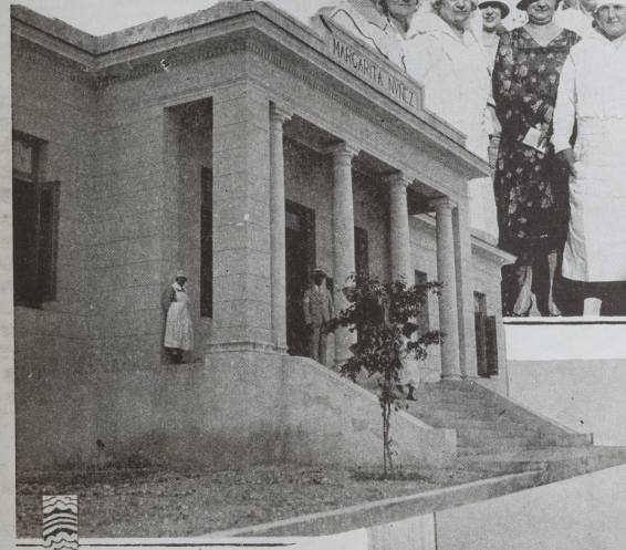
Fachada de la clínica "Margarita Núñez", inaugurada recientemente en terrenos del hospital "Calixto García".
